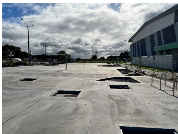
Above: concrete pour for the half court
